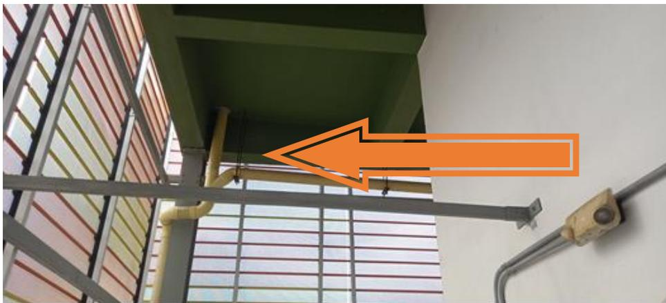
Las tuberías quedaron suspendidas en el aire, además de no ser estético, los soportes frágiles
